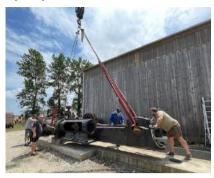
Des années que nous en rêvions! Le moteur vapeur Dujardin sorti d'une scierie landaise est sur le point de trouver sa place sur le site du hangar. Les maçons de service ont depuis longtemps préparé le support et la grue de cinquante tonnes est enfin là pour une manutention aussi délicate
